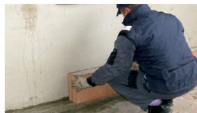
Applicazione del primo corso di Porotherm Revolution
