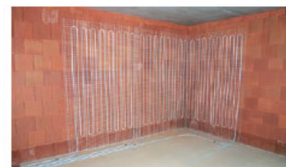
Porotherm Revolution fornisce un supporto ottimale per il montaggio di sistemi di riscaldamento a parete.
