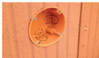
Installazione delle scatole di derivazione per l'impianto elettrico
