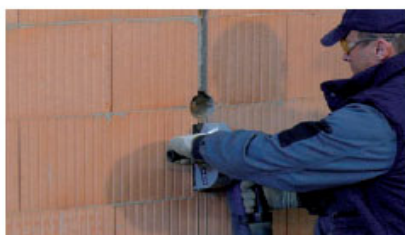
Realizzazione delle tracce con opportuno scanalatore
