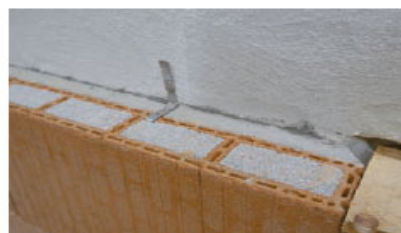
Realizzazione dell'ancoraggio della controparete alla parete esistente ogni 3 corsi in altezza a distanza orizzontale di 1,5 m*
