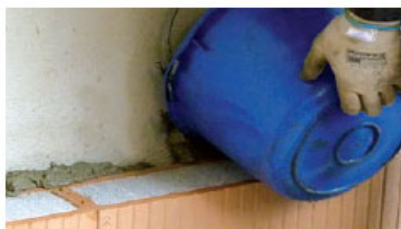
Riempimento dell'intercapedine con malta di allettamento
