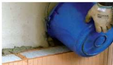
Riempimento dell'intercapedine con malta di allettamento
