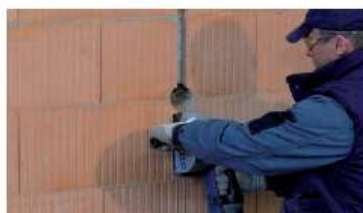
Realizzazione delle tracce con opportuno scanalatore
