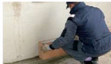
Applicazione del primo corso di Porotherm Revolution
