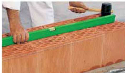
Livellamento del primo corso
