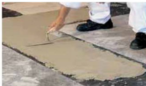
Predisposizione della guaina per l'umidità di risalita
