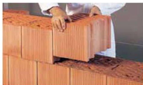
Posa dei blocchi
