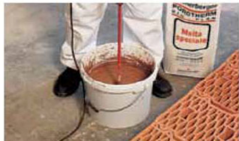
Preparazione della malta speciale
