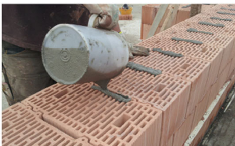
Riempimento delle tasche di malta.
