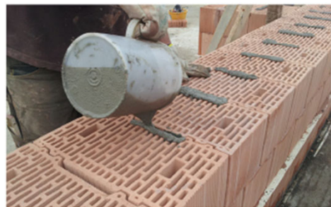
Riempimento delle tasche di malta.
