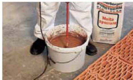
Preparazione della malta speciale
