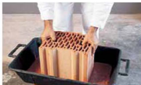
L'applicazione della malta per immersione
