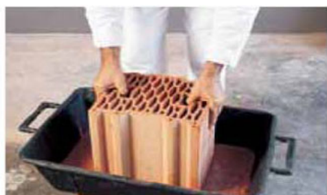
L'applicazione della malta per immersione
