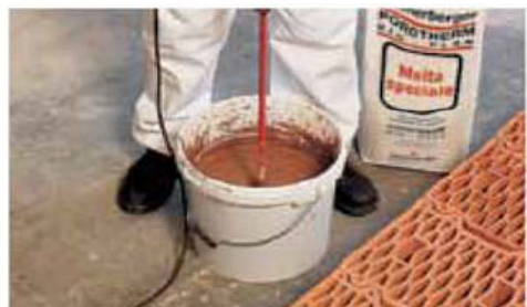
Preparazione della malta speciale
