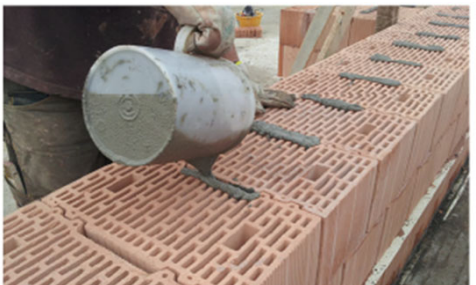
Riempimento delle tasche di malta.
