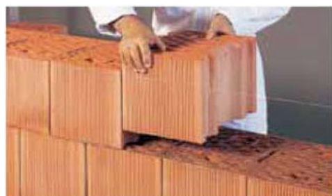
Posa dei blocchi
