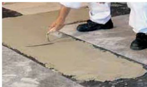
Predisposizione della guaina per l'umidità di risalita
