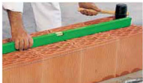
Livellamento del primo corso
