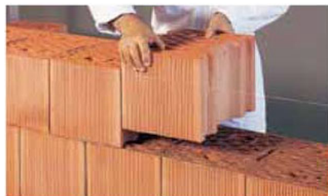
Posa dei blocchi
