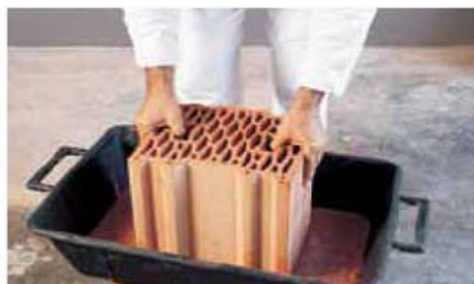
L'applicazione della malta per immersione
