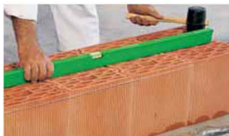
Livellamento del primo corso
