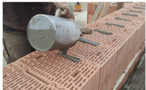
Riempimento delle tasche di malta.
