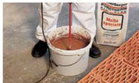
Preparazione della malta speciale
