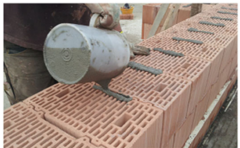
Riempimento delle tasche di malta.
