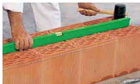
Livellamento del primo corso
