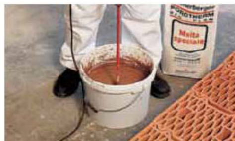
Preparazione della malta speciale
