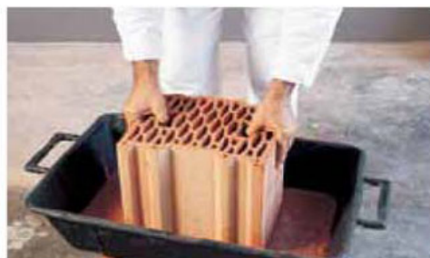
L'applicazione della malta per immersione
