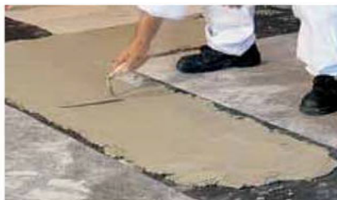
Predisposizione della guaina per l'umidità di risalita
