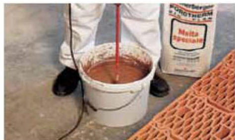
Preparazione della malta speciale
