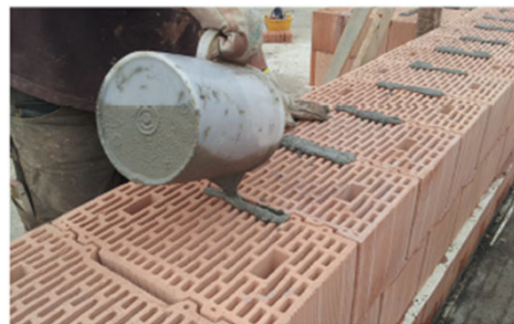
Riempimento delle tasche di malta.
