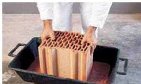
L'applicazione della malta per immersione
