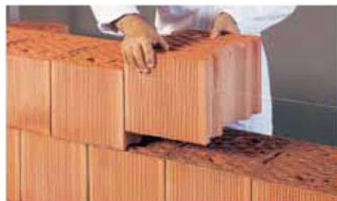
Posa dei blocchi
