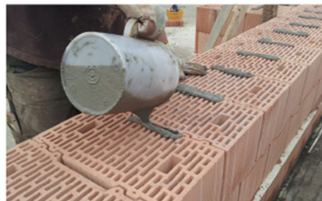
Riempimento delle tasche di malta.
