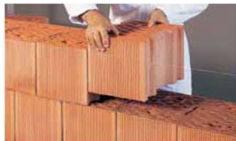
Posa dei blocchi
