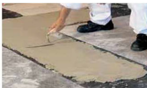
Predisposizione della guaina per l'umidità di risalita
