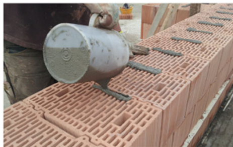
Riempimento delle tasche di malta.
