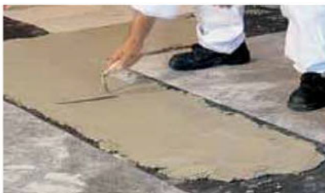
Predisposizione della guaina per l'umidità di risalita
