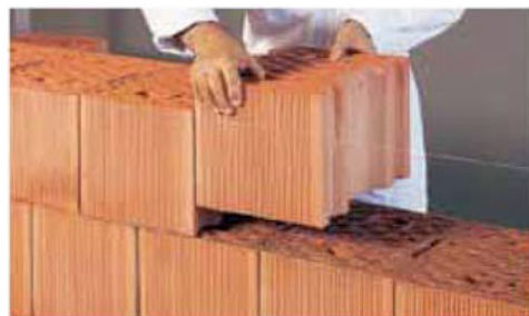
Posa dei blocchi
