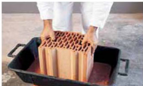
L'applicazione della malta per immersione
