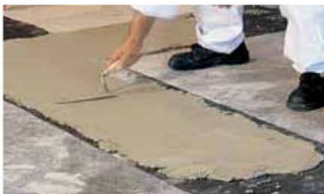
Predisposizione della guaina per l'umidità di risalita
