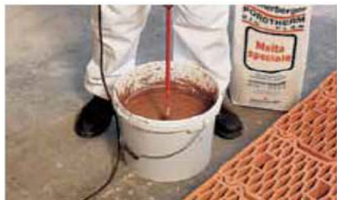
Preparazione della malta speciale
