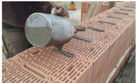
Riempimento delle tasche di malta.
