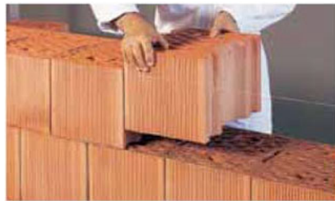
Posa dei blocchi
