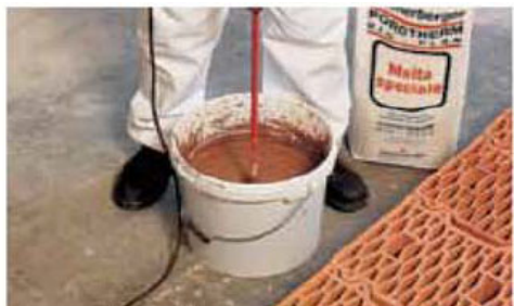
Preparazione della malta speciale
