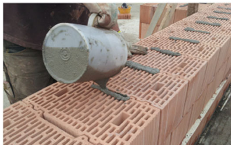
Riempimento delle tasche di malta.
