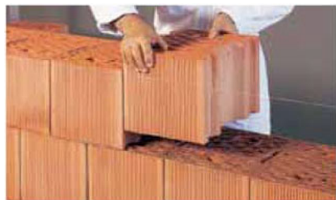
Posa dei blocchi
