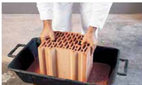
L'applicazione della malta per immersione
