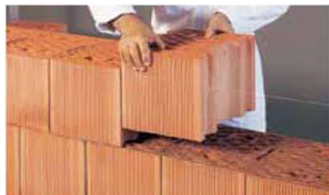
Posa dei blocchi
