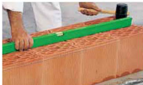
Livellamento del primo corso
