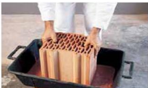
L'applicazione della malta per immersione
