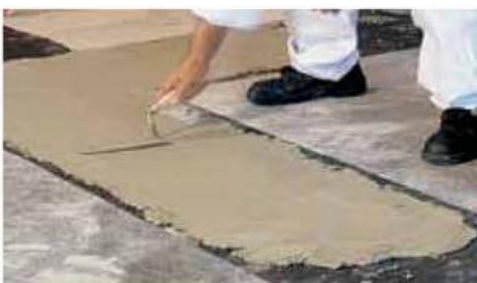
Predisposizione della guaina per l'umidità di risalita
