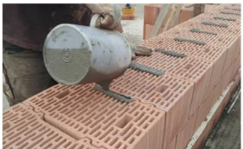
Riempimento delle tasche di malta.
