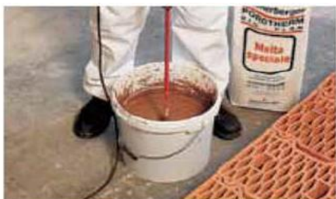
Preparazione della malta speciale
