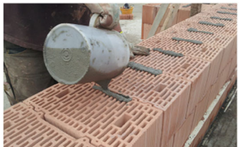
Riempimento delle tasche di malta.
