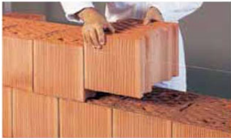
Posa dei blocchi
