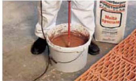
Preparazione della malta speciale
