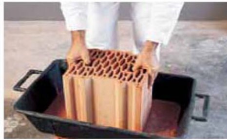
L'applicazione della malta per immersione
