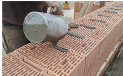
Riempimento delle tasche di malta.
