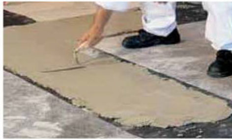
Predisposizione della guaina per l'umidità di risalita
