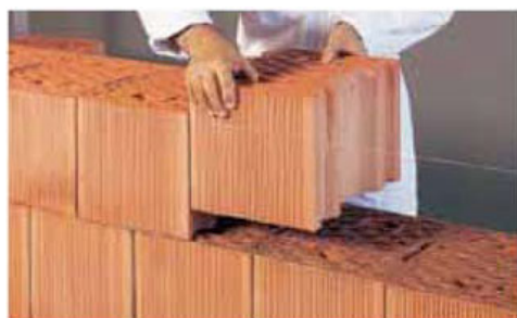
Posa dei blocchi
