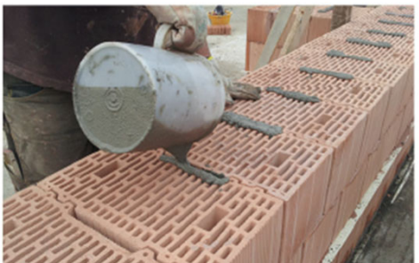
Riempimento delle tasche di malta.
