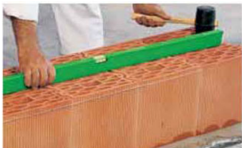
Livellamento del primo corso
