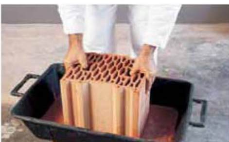
L'applicazione della malta per immersione
