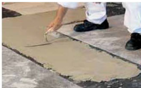
Predisposizione della guaina per l'umidità di risalita
