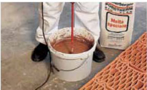
Preparazione della malta speciale
