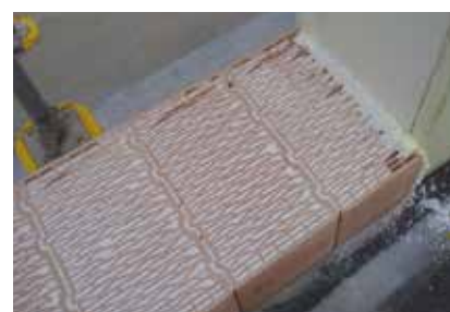
Isolamento del primo corso realizzando il riempimento dei blocchi in cantiere con perlite sfusa. Maggiori dettagli a pagina 58.
