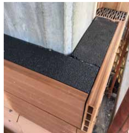
Posa in opera del Porotherm Thermal T nei pilastri d'angolo del telaio del c.c.a.
