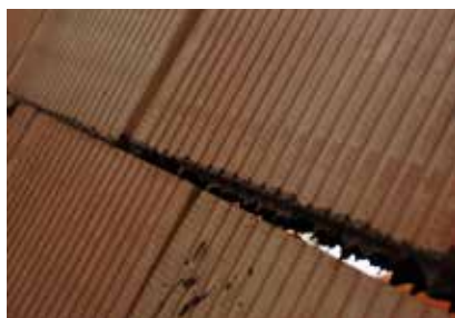
Dettaglio del giunto di malta di 1 mm.
