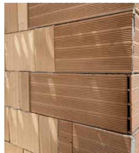
Particolare della posa in opera sulla faccia esterna del pilastro d'angolo del Porotherm Thermal T
