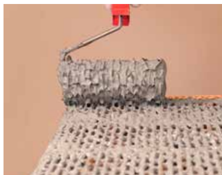
Posa in opera con realizzazione del giunto di malta sottile con l'apposito rullo stendi-malta
