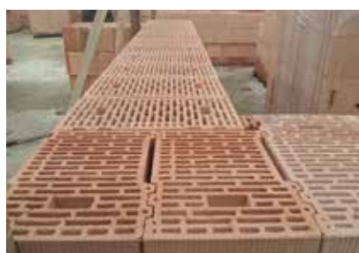
Ammorsamento dell'angolo per la muratura portante.
