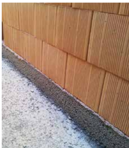
Particolare del massetto di livellamento a bolla per la posa in opera del primo corso di blocchi
