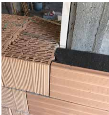
Posa in opera del Porotherm Thermal T in combinazione con i blocchi rettificati
