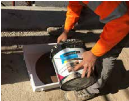
Preparazione in cantiere della Malta Speciale Porotherm (fornita insieme ai blocchi rettificati in sacchi da 25 kg)
