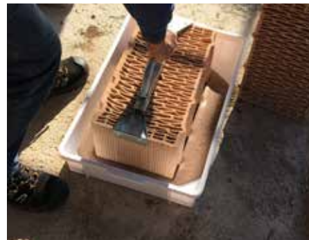
Posa in opera dei blocchi per immersione in una vaschetta, movimentazione agevolata dall'uso della maniglia
