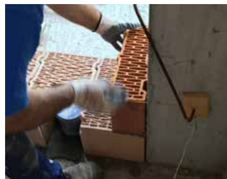
Posa in opera dei blocchi con l'aiuto del filo per mantenere l'allineamento verticale della muratura
