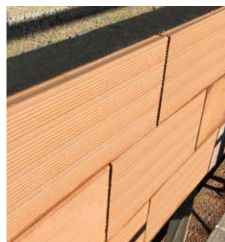
Posa in opera del Porotherm Thermal T sul cordolo esterno de solaio
