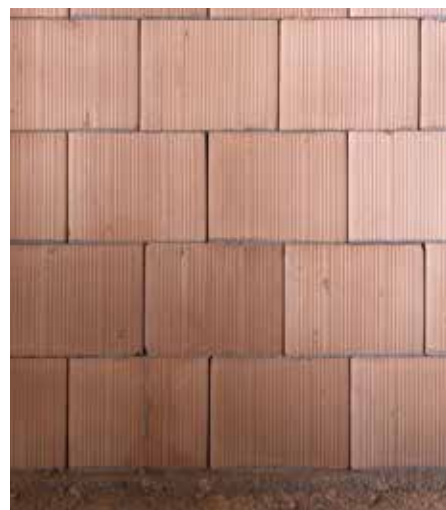
Particolare della parete realizzata con blocchi rettificati. Si noti l'allineamento dei giunti orizzontali di malta
