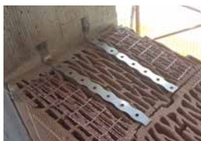
Connessione del blocco rettificato al telaio in c.c.a. tramite ancoraggi.
