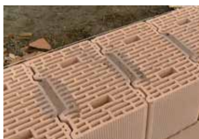
Riempimento della tasca nei blocchi a incastro per muratura portante.
